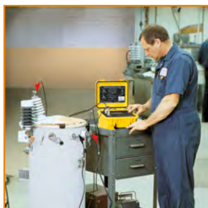
Messung an einem Transformator in einer Werkstatt
